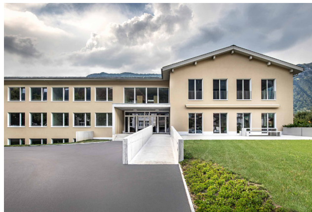
Erweiterungsbau Schulhaus Bönigen
