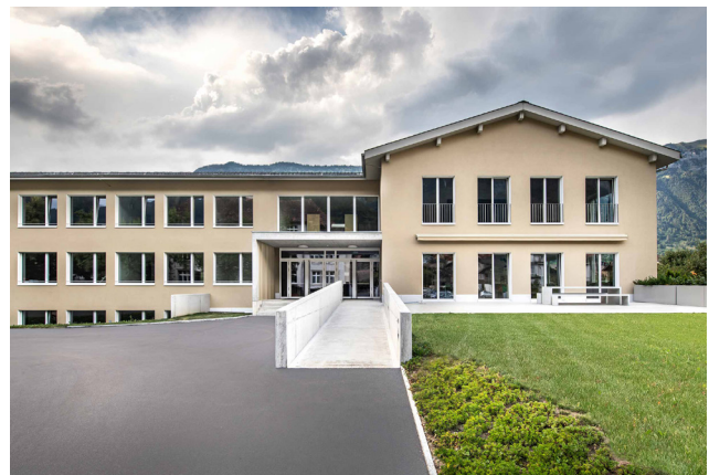
Erweiterungsbau Schulhaus Bönigen
